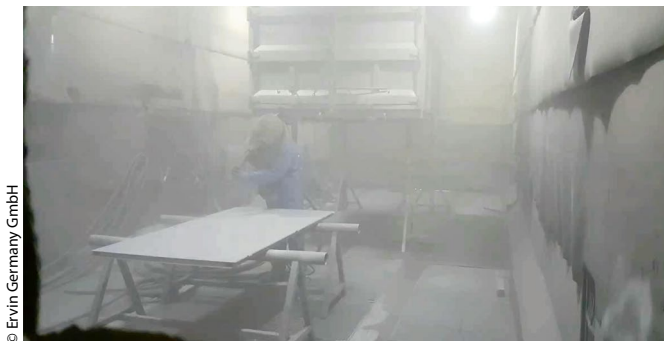
Bild 1 > Beim Strahlen mit Korund tritt eine starke Staubentwicklung auf, die zu schlechten Sichtverhältnissen führt.
